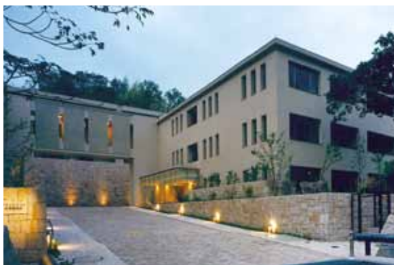
外観とのバランスを意識して、壁面ごとに開口部に統一感を持たせながら、リズム感を演出。主開口面と道路の間には植栽帯を設け、通りからの視線をほどよく遮っています。(GM音楽園桜町/兵庫県)
