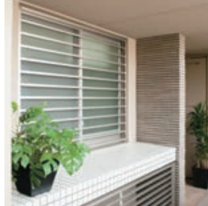
窓の面格子は室内からの眺めの魅力を半減させているかもしれませんが、侵入犯に「ガードが固い」と思わせるための大切な防犯要素です。
